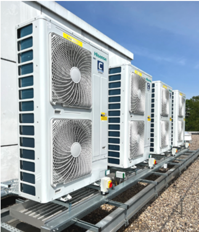
Die von außen an den Lüftungsanlagen angebrachten Steuereinheiten für externe Wärmeübertrager
