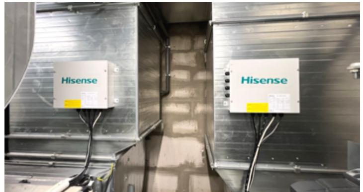
Die von außen an den Lüftungsanlagen angebrachten Steuereinheiten für externe Wärmeübertrager
