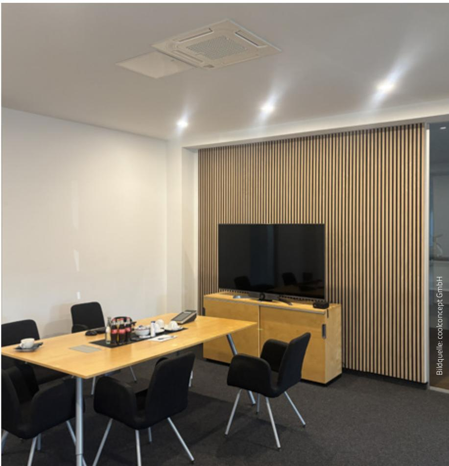
*Mini-Kassettengeräte von Hisense mit zugfreiem 360°-Luftaustritt*
