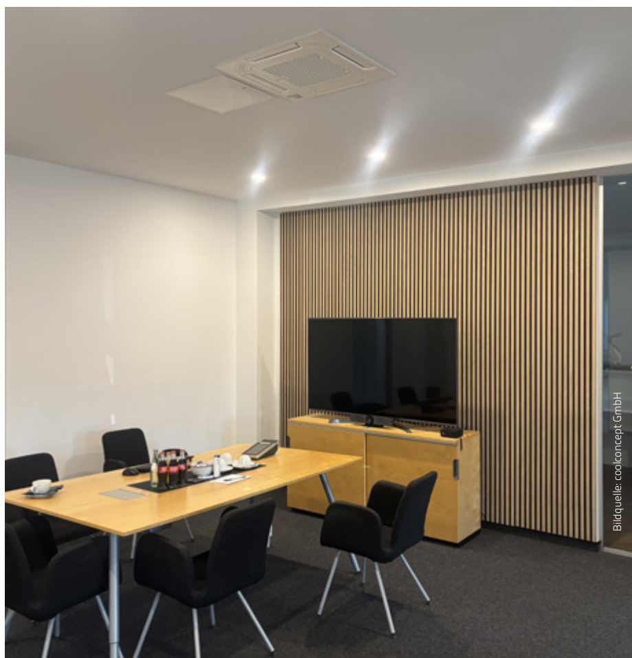
Mini-Kassettengeräte von Hisense mit zugfreiem 360°-Luftaustritt
