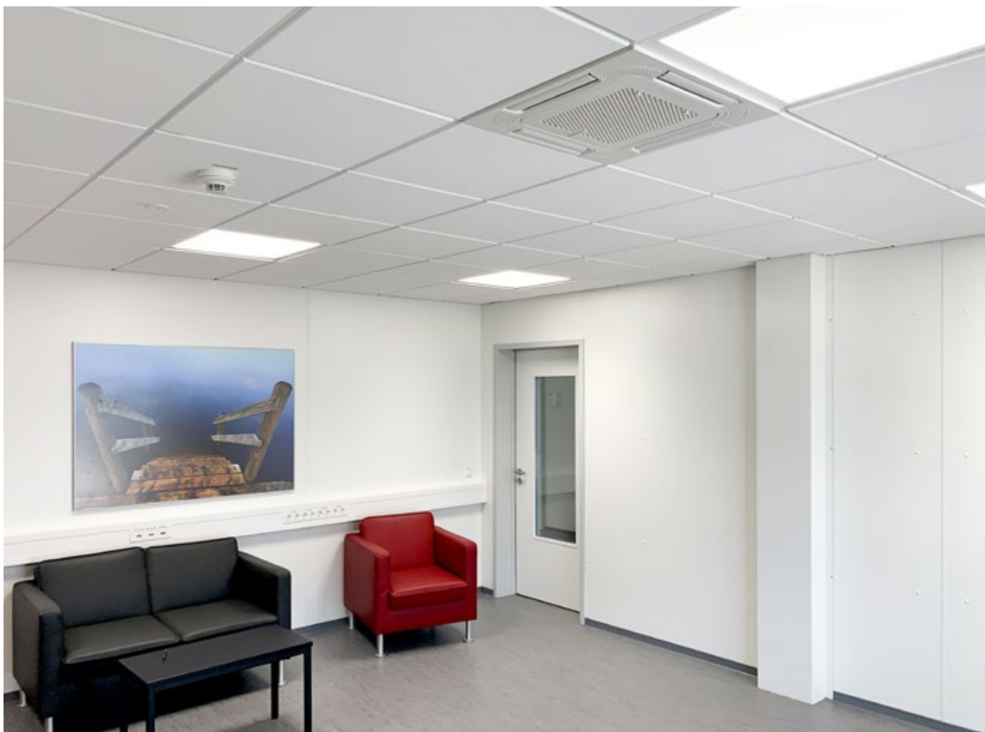
Optimale Integration der Kassettengeräte in die Odenwalddecken
