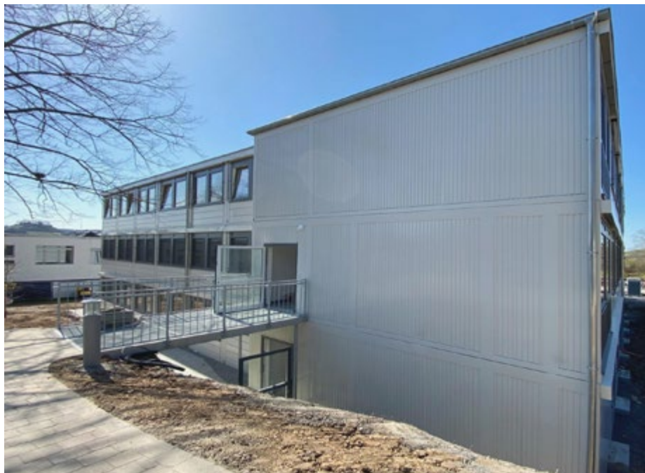
Modulraumgebäude der Fachklinik in Weinsberg
