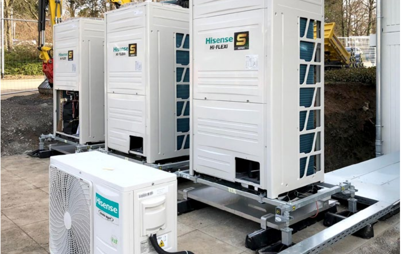
Bodenmontage der PAC- und VRF-Außeneinheiten
