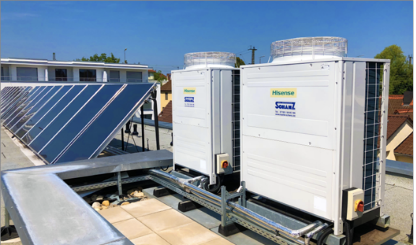
Dachinstallation der Außeneinheiten
