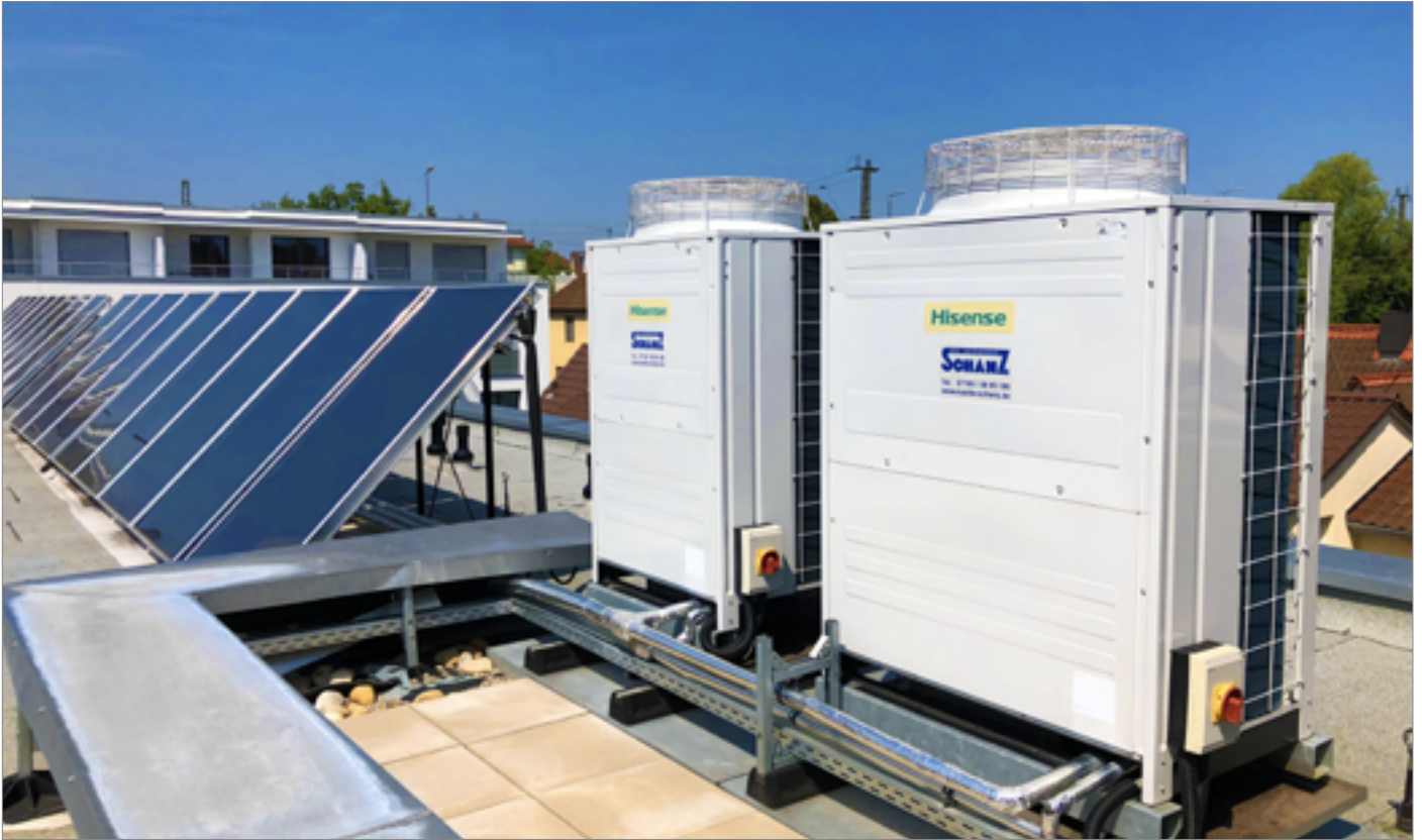
Dachinstallation der Außeneinheiten
