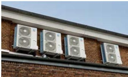
PAC Außeneinheiten von Hisense – Für kurze Leitungswege wurden die Außengeräte oberhalb eines Vorsprungs an der Fassade des Gebäudes installiert.
