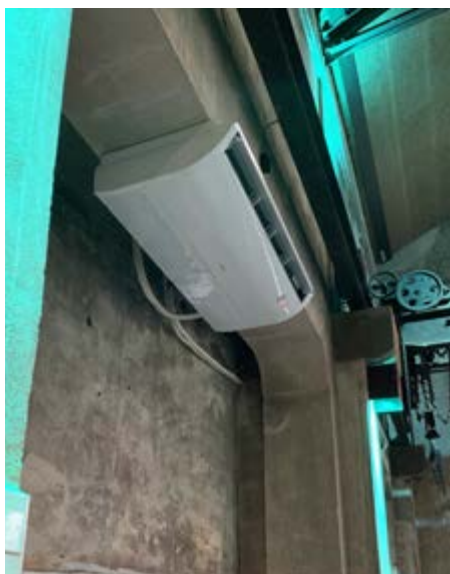
PAC Außeneinheiten von Hisense – Für kurze Leitungswege wurden die Außengeräte oberhalb eines Vorsprungs an der Fassade des Gebäudes installiert.
