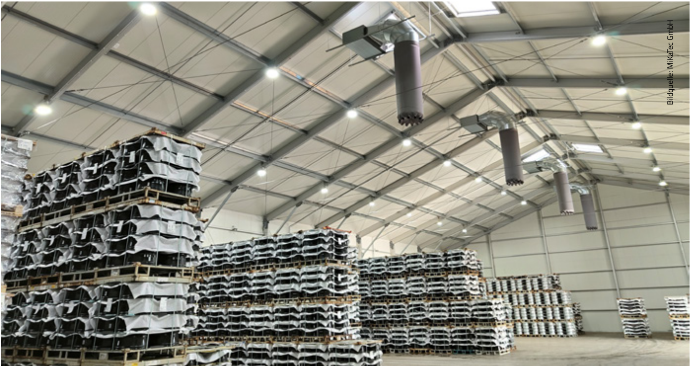
Hisense-Kanalgeräte mit speziellen Luftsäcken zur Sicherung einer gleichmäßigen Luftverteilung
