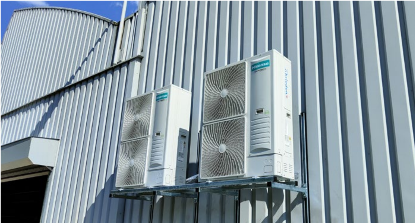
An der Fassade montierte PAC Außeneinheiten von Hisense
