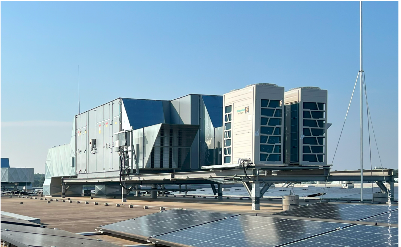
Synergie auf dem Dach: Moderne Lüftungsanlagen (AHUs) mit integrierten Hisense VRF-Außengeräten, umgeben von einer leistungsstarken PV-Anlage
