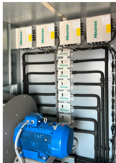
Die HZX-Kits von Hisense regeln die thermische Energieübertragung im Luftkanal per 0–10 V-Signal
