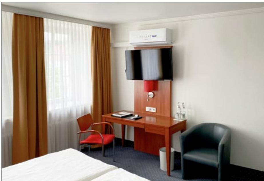
**VRF Wandgerät** von Hisense mit einem „Easy Installation“-Gehäuse
