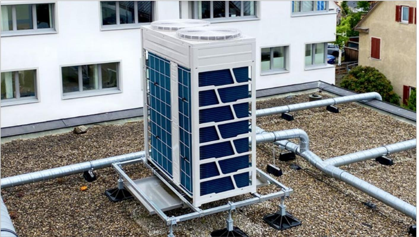
VRF Außengerät von Hisense auf dem Flex-O-Frame-Montagegestell
