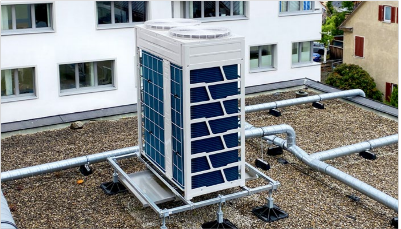
VRF Außengerät von Hisense auf dem Flex-O-Frame-Montagegestell
