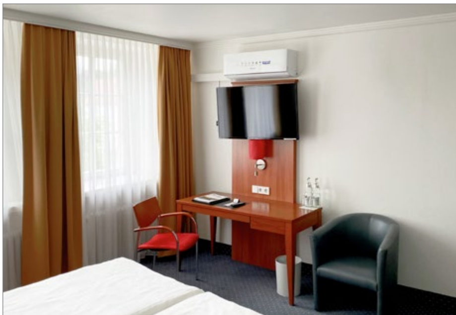
VRF Wandgerät von Hisense mit einem „Easy Installation“-Gehäuse
