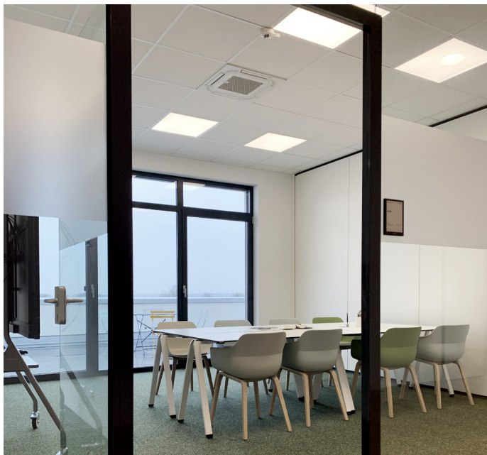
Kassettengeräte mit 360° Luftstrom
