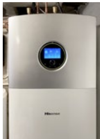
Regelmodul der Combi-Split-Inneneinheit mit Klartextdarstellung und Bedienung über Dreh-/Drücksteller im Betrieb
