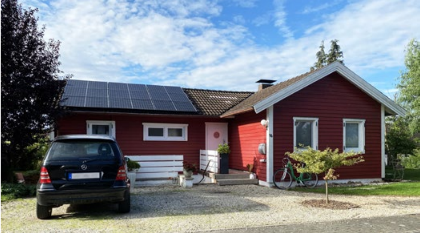
Energetisch saniertes Eigenheim in Kirtorf mit Wärmepumpensystem ausgestattet
