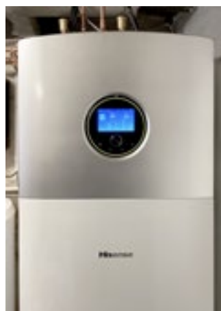
Regelmodul der Combi-Split-Inneneinheit mit Klartextdarstellung und Bedienung über Dreh-/Drücksteller im Betrieb
