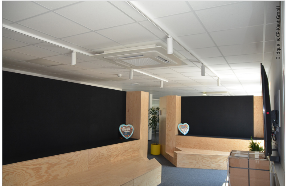
VRF Kassettengeräte mit 360°-Airflow von Hisense
