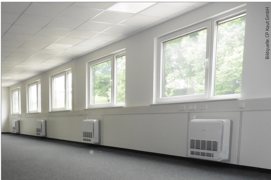
VRF Bi-Flow Truhengeräte mit optimierter Luftführung von Hisense
