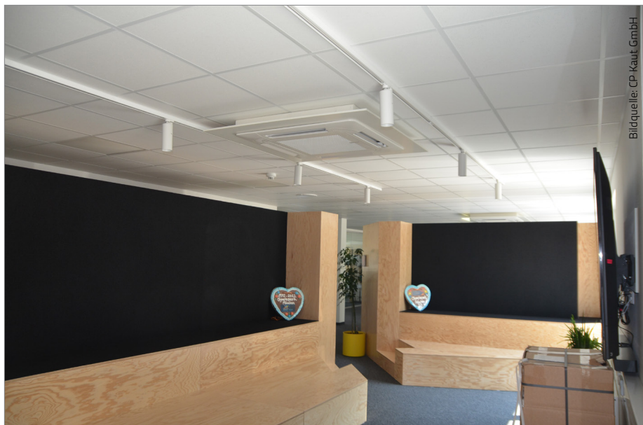
VRF Kassettengeräte mit 360°-Airflow von Hisense
