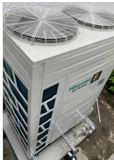
VRF-Außengerät der neuen S-Serie
