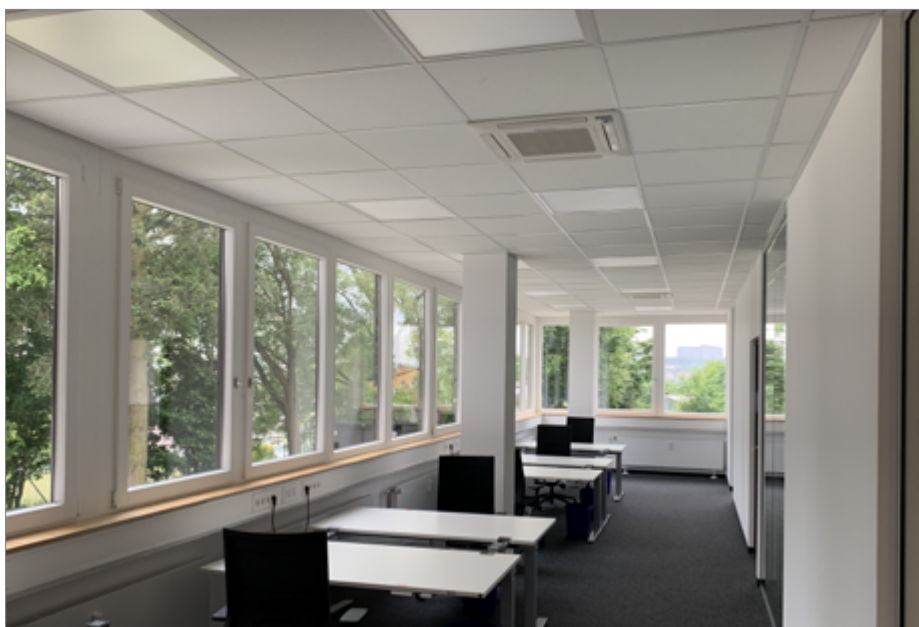
Odenwalddecke mit verbauten Eurorastermaßkassetten
