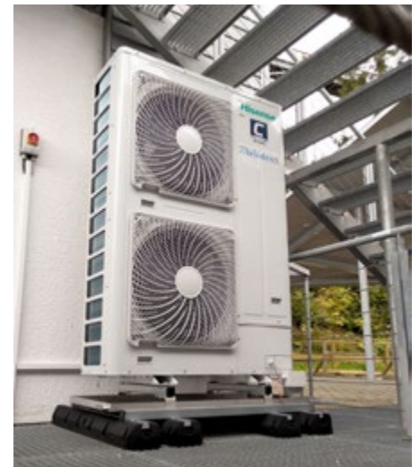
VRF MINI-Außeneinheit von Hisense
