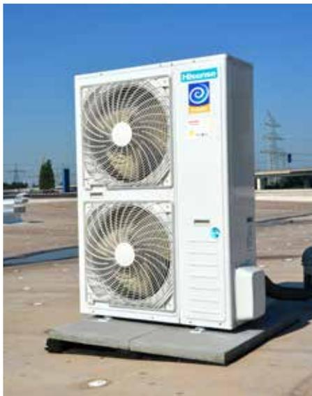
minimalen Kühlleistung von 7,0 kW und einer großzügig bemessenen Verdampferoberfläche ist auch hier die Ausfallsicherheit der wichtigen Server für die Logistik gesichert.
