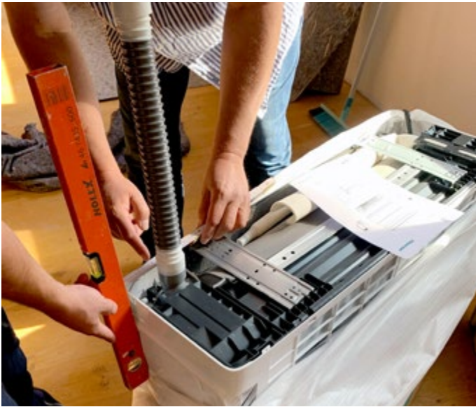
Der Schlauch für die Frischluftzufuhr wird einfach an den vorgesehenen Anschluss gesteckt, bei Bedarf kann er gekürzt oder verlängert werden.
