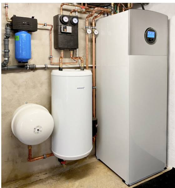
Inneneinheit, Trinkwasser- und Pufferspeicher, Ausdehnungsgefäße und die dazugehörige Mischgruppe wurden nach der VDI 4645 ausgelegt
