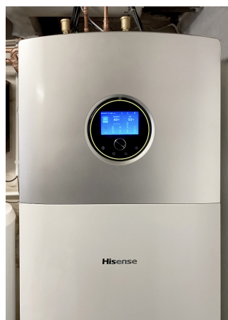
Regelmodul der Combi-Split-Inneneinheit mit Klartextdarstellung und Bedienung über Dreh-/Drücksteller
