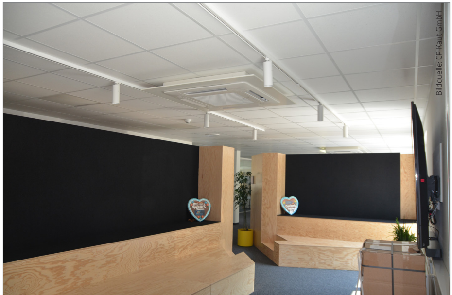
VRF Kassettengeräte mit 360°-Airflow von Hisense
