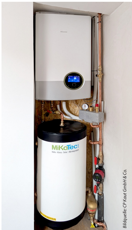
Inneneinheit und 150-Liter-Pufferspeicher
