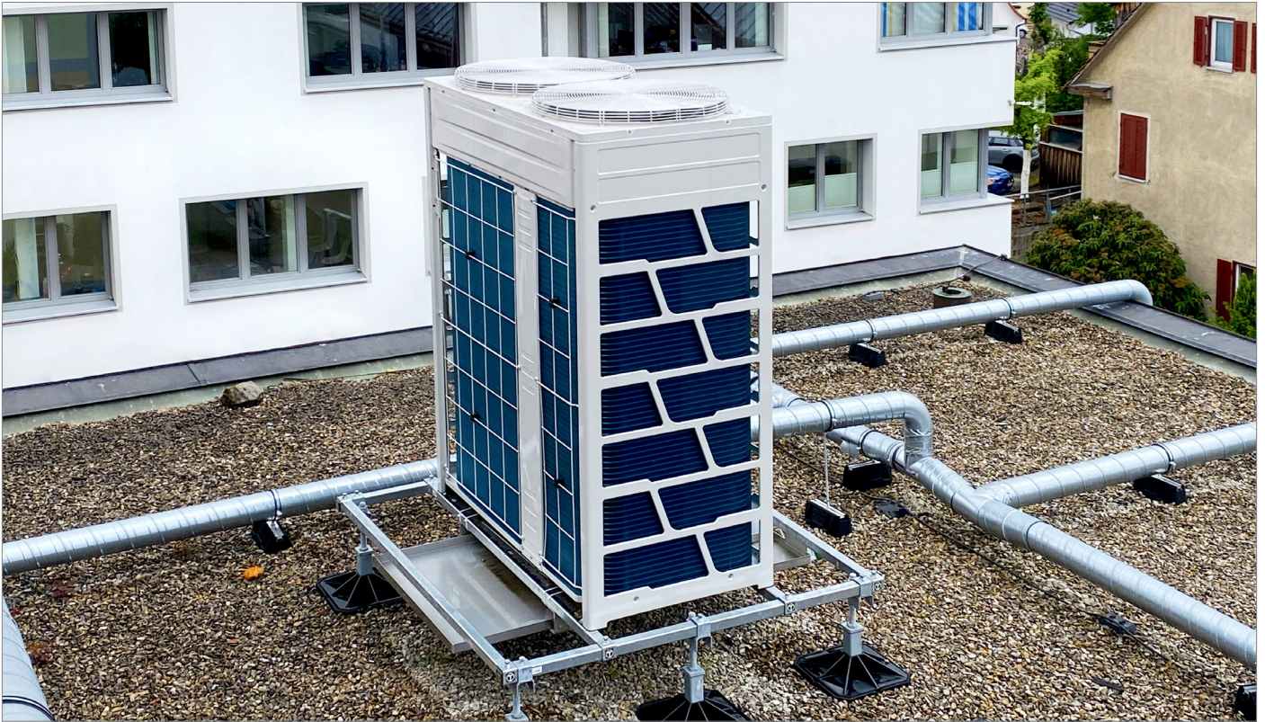
VRF Außengerät von Hisense auf dem Flex-O-Frame-Montagegestell
