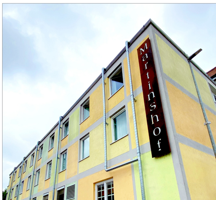
Rohrleitungssystem auf der Gebäuderückseite in Sichtmontage verlegt
