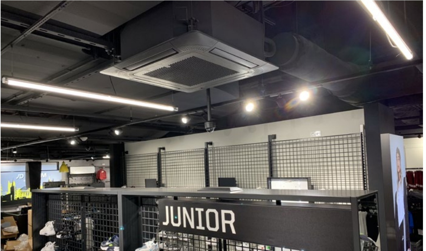
Installation der Kassettengeräte im Eurorastermaß
