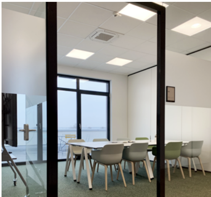
Kassettengeräte mit 360° Luftstrom
