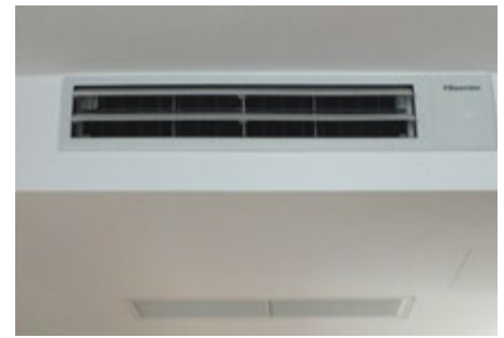
Hisense VRF 3D-Luftausblasgitter mit variabel einstellbaren Lamellen
