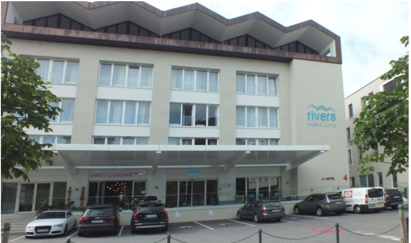
Rivers Hotel & Living mit Hisense VRF-Systemen klimatisiert
