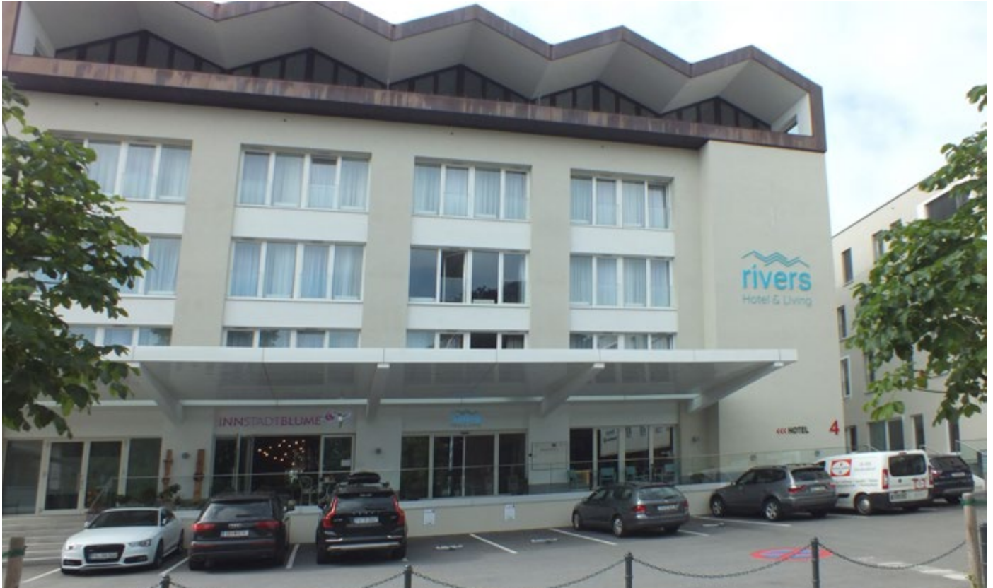
Rivers Hotel & Living mit Hisense VRF-Systemen klimatisiert
