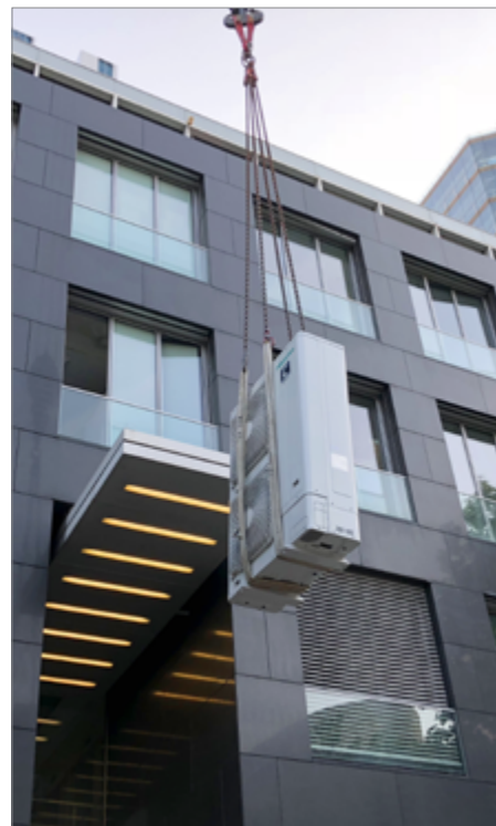
Transport der Außeneinheiten
