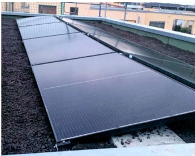
Die auf dem Dach installierte Photovoltaik-Anlage ist mit dem Klimasystem gekoppelt, deren Leistung den Energiebedarf der Klimaanlage abdeckt
