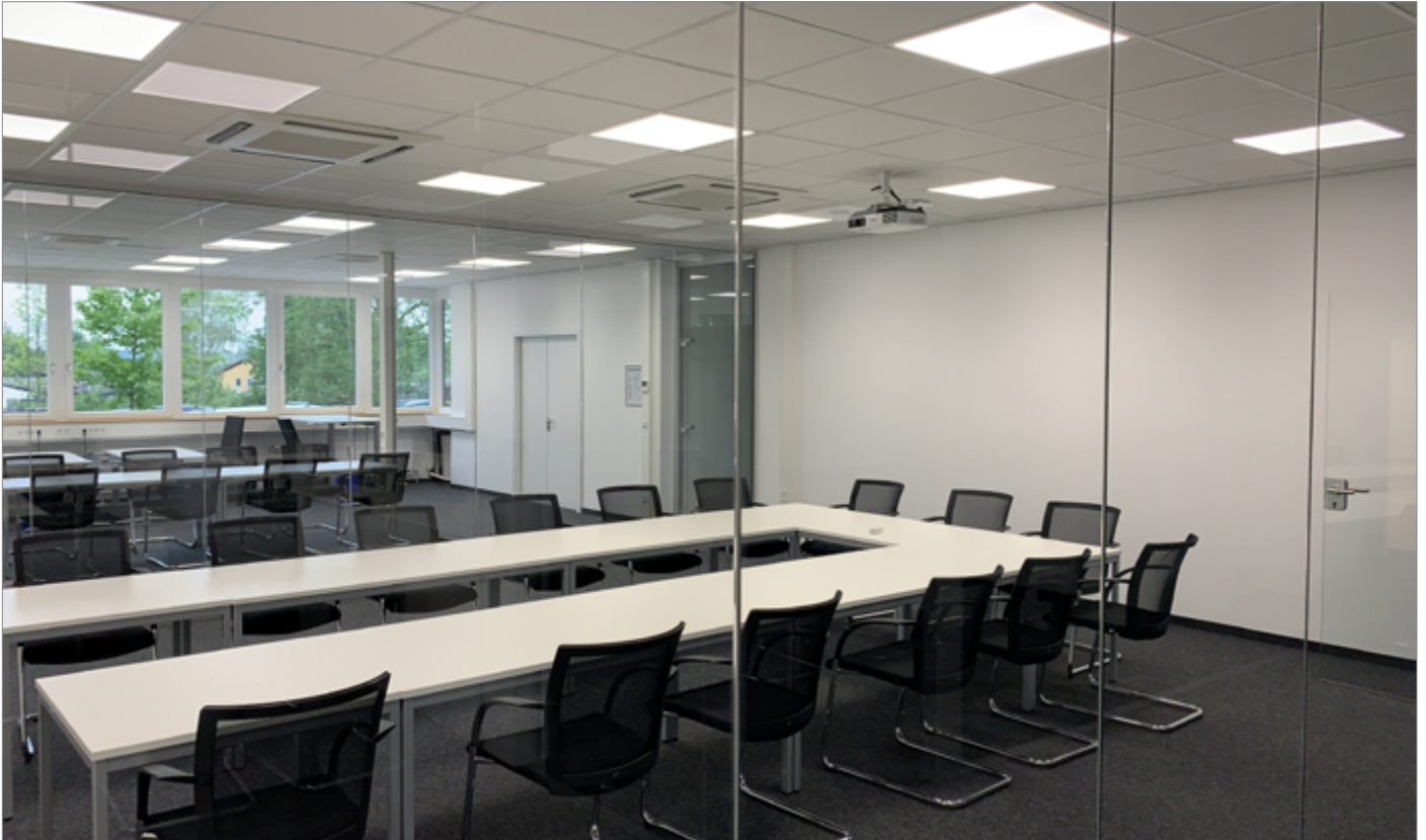
Kassettengeräte mit Frischluftanschluss
