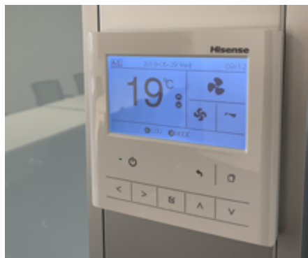
Kabelfernbedienung mit Sensorik-Feld
